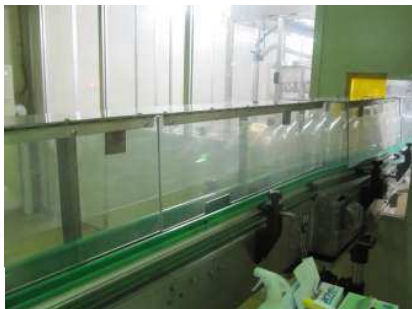
この部分からオゾン水にて ボトル洗浄(15 秒) ドレン受け、カバー等の工事が必要
