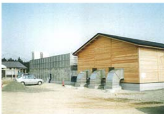
反応槽 オゾン機械室
