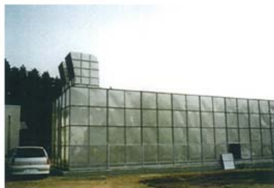
反応槽 排出口
