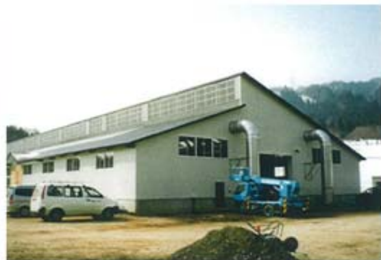
堆肥舎 毎分1640㎡処理
