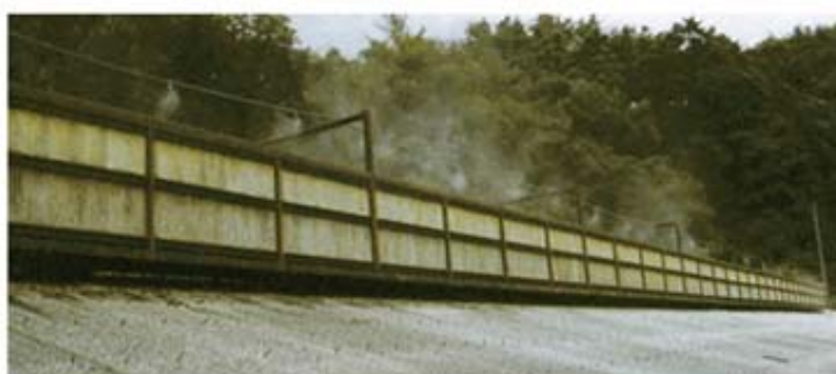
処理場のオゾン水による脱臭(開閉型)日量80トン処理
